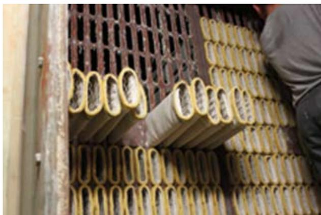
Les incidents sur le traitement des fumées sont essentiellement dûs à des dommages sur les filtres à manches (manches percées, chutes d'embouchures...).
